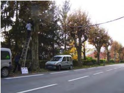
Pose d'une passerelle à écureuil sur la RD520, à Voiron en 2010
