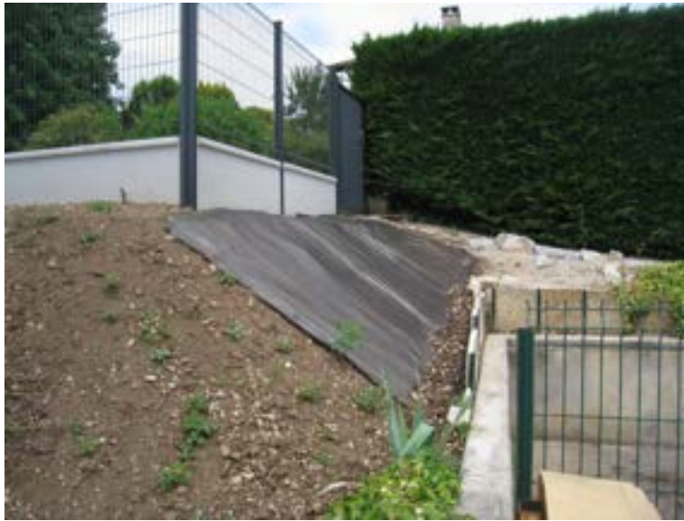
Photo 35 : bâche « Paillex » sur talus.
