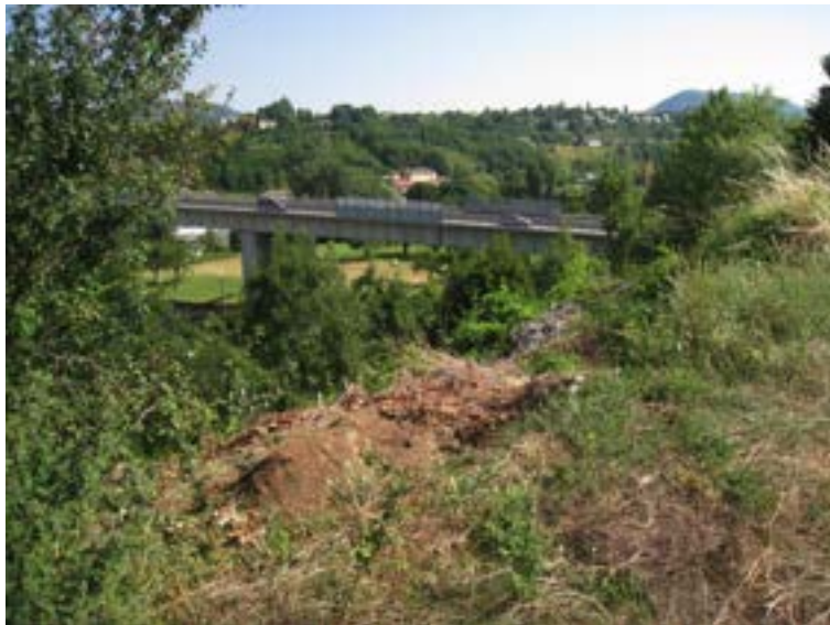
Photo 27 : dépôt de déchets au dessus de la voie ferrée, Le Veyet. M. Botton
